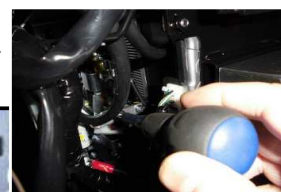
ドライバーで配線締め付け→
