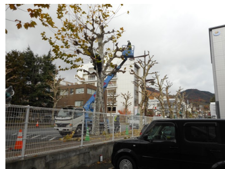
建荷協長野支部付近の冬支度作業(街路樹の枝払い作業)
